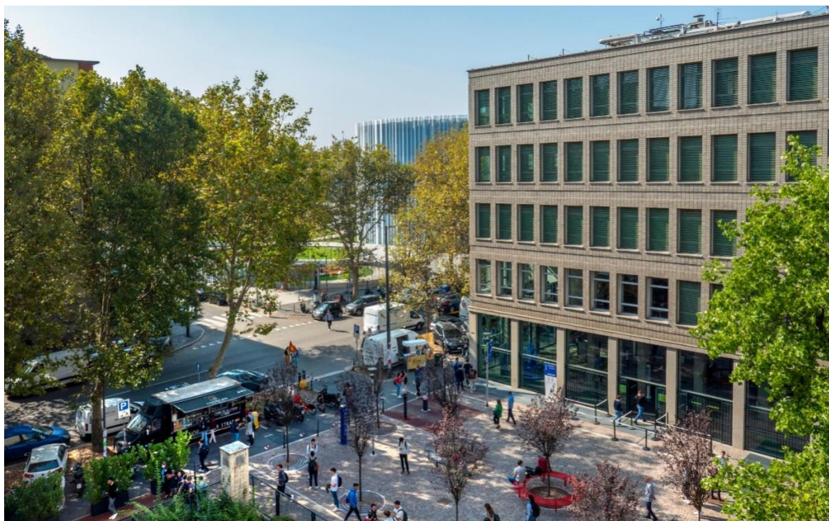
Figura 37 - Esterno della Biblioteca Bocconi (via Ulisse Gobbi 5)
